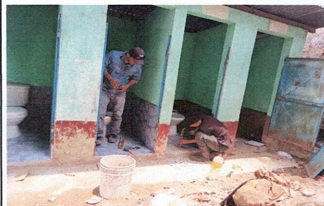
Foto 4: Colocación de azulejo para los baños.
