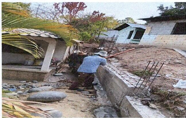
Foto 1: Colocacion de varilla de soporte a muro de contención.
