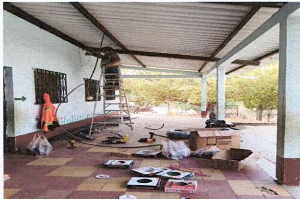
Foto 3: Colocación de nuevo cable para sistema Eléctrico.
