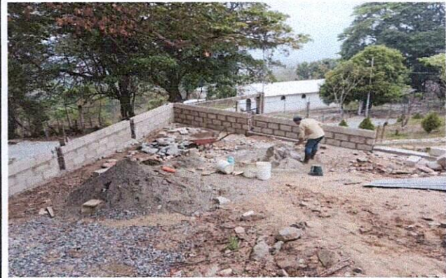
Foto 2: Colocación de block a muro de contención.
